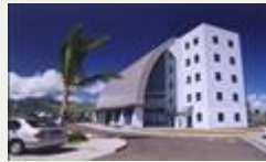
Free Port Administra- tion Building-Mauritius
